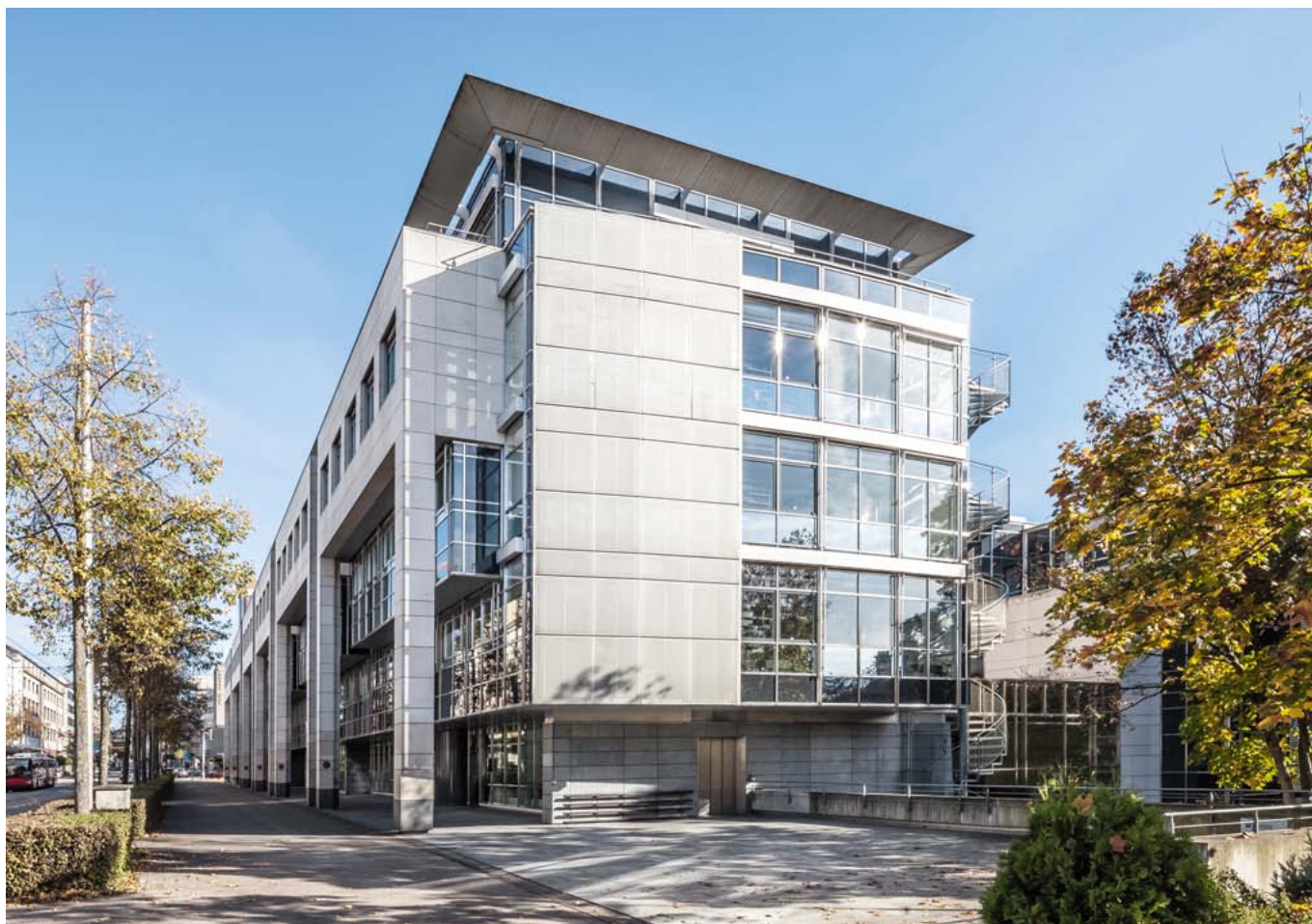
L'edificio della nuova sede principale della FINMA ubicato in Laupenstrasse, a Berna.
